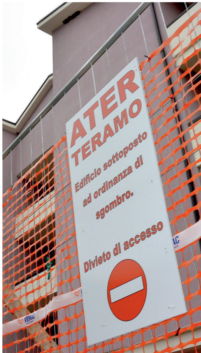
Un palazzo Ater danneggiato dal terremoto
